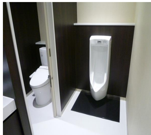
トイレ 改修後
